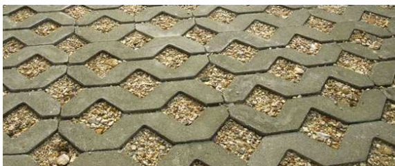
Figure 27 – Caillebotis en béton
